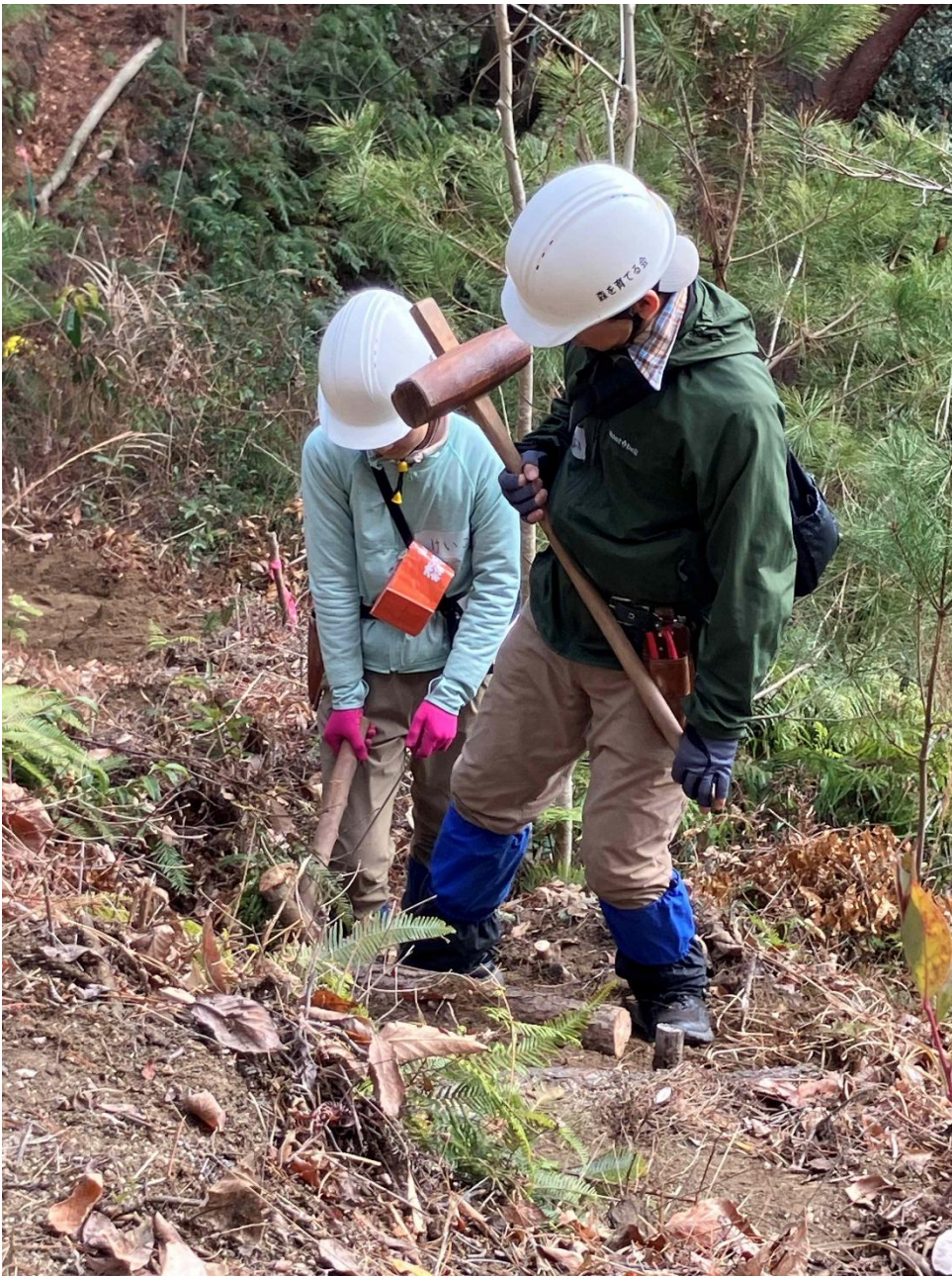
【アカマツ林の作業道に階段整備】
