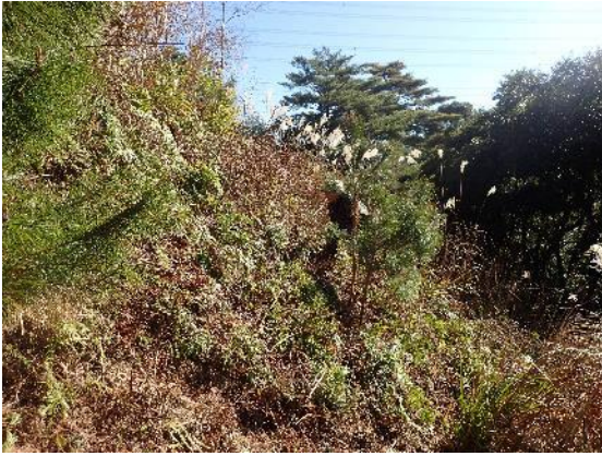
〈急斜面の作業です。〉
